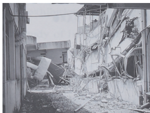
圖 2-71：九二一大地震工藝所工場 震毀一隅《臺灣工藝》，No.1
