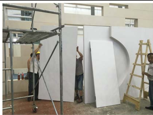
內部牆面施工
