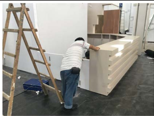
服務台施工中
